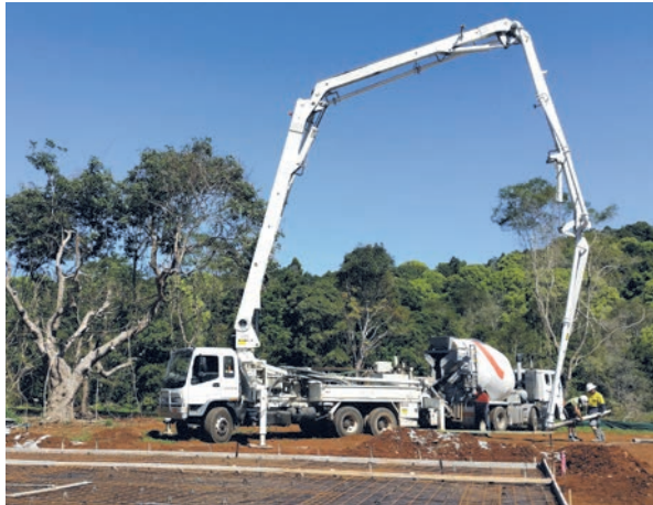
Pouring the slab.
